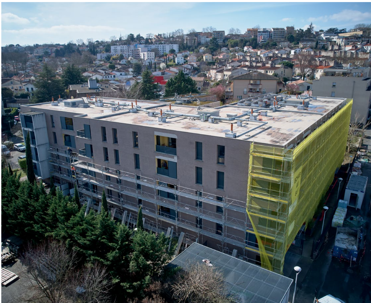
Copropriétés Desgraves Toulouse. Chantier de rénovation de la résidence
